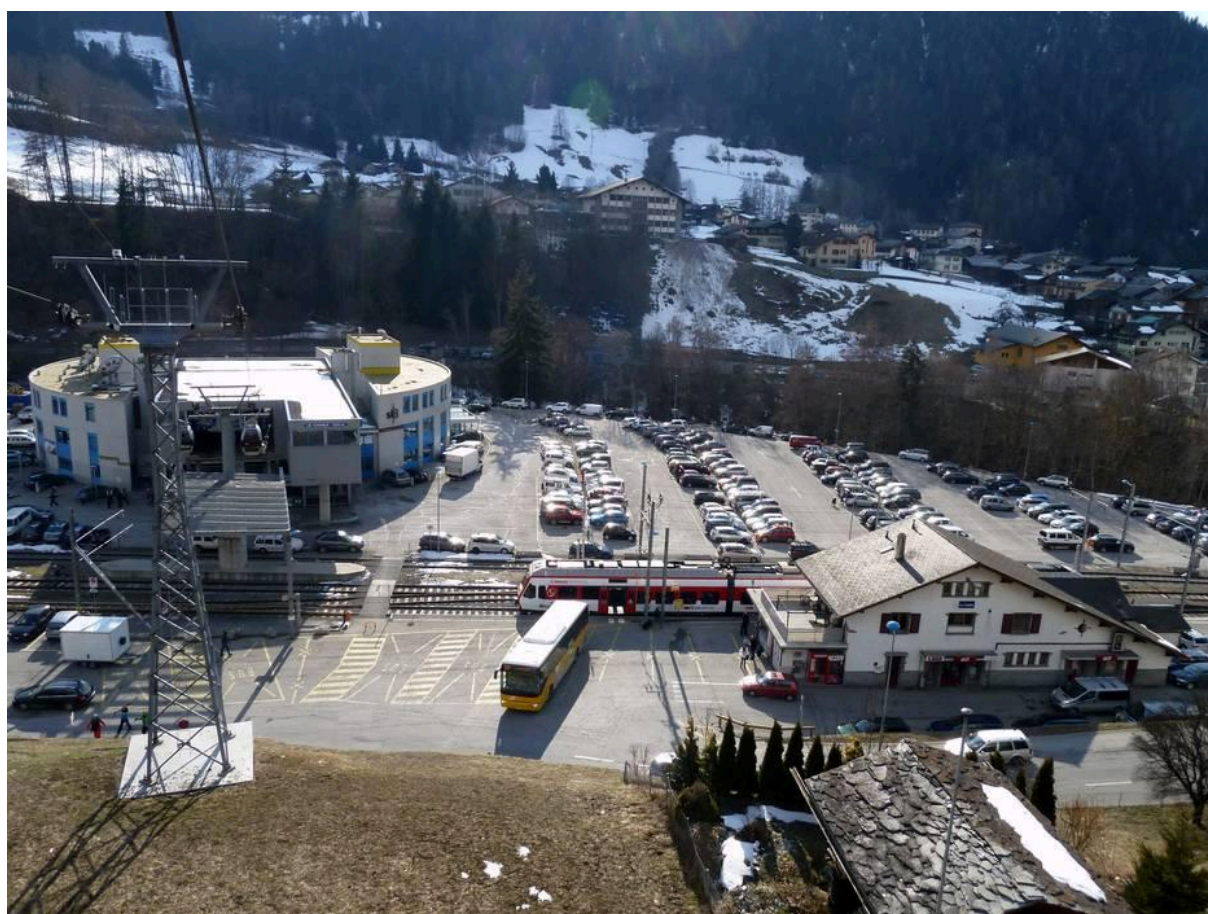
Figure 75: gare d'arrivée du télécabine à Le Châble. Source: Skiresort.fr
