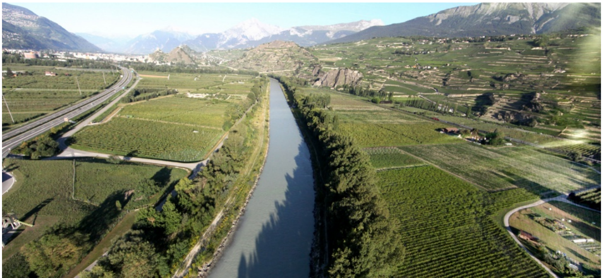
Figure 49: le Rhône à la hauteur des terres agricoles d'Uvrier. Le projet de troisième correction y prévoit un élargissement. La coordination engagée entre le Canton et les agriculteurs lors de l'élaboration du plan d'aménagement de la 3 e correction du Rhône se poursuivra et permettra d'intégrer au mieux le projet dans son contexte agricole. Photo par paysagegestion et localarchitecture.
